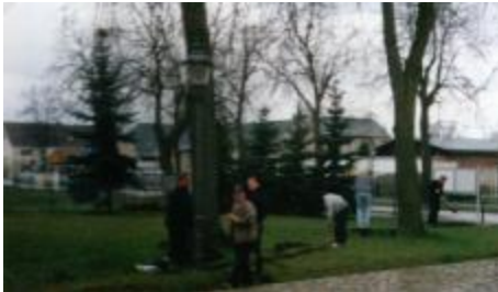
Der Kabelkanal wird gegraben
