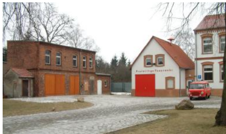
Das fertig gestellte neue Feuerwehrdepot mit Nebenglass
