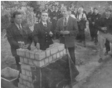
v.l. Bürgermeister Wolfgang Sasse, Wehrleiterin B.Witt, Amtsdirektor R.Dellmann bei der Grundsteinlegung
