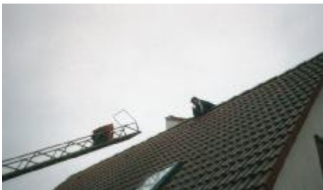
Die wirklich schwere Sirene wird auf's Dach gehoben.
